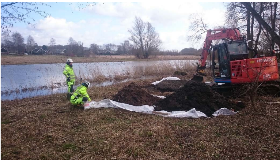
Figur 9: Översiktsbild grävning i område E. Foto taget mot öster.
