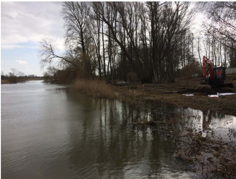
Figur 10: Översiktsbild område D. Foto taget mot söder och grävning i område E från brygga.
