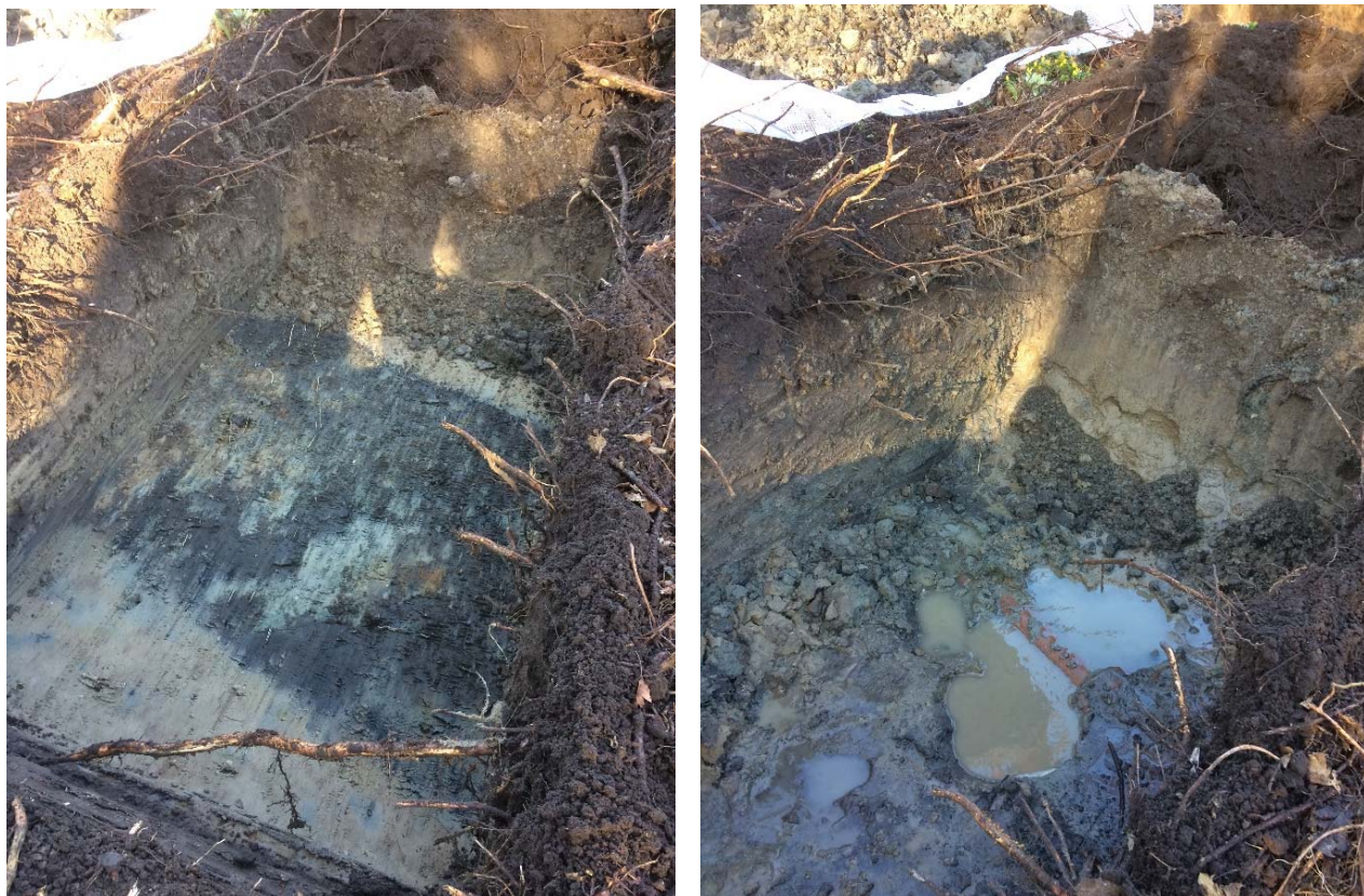
Figur 4: Grop nr 1 i område C. Foto till vänster är taget strax innan vatten börjar tränga in. Ledningen återfinns i det mörkare stråk som noteras i botten. Foto taget mot nordväst. Fotot till höger är taget några minuter efter att ledningen grävts fram.
