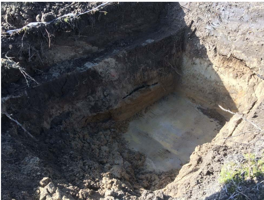
Figur 2: Grop område B där vatten börjar tränga in i botten på ca 1,6 m u my. Foto taget mot väster.
