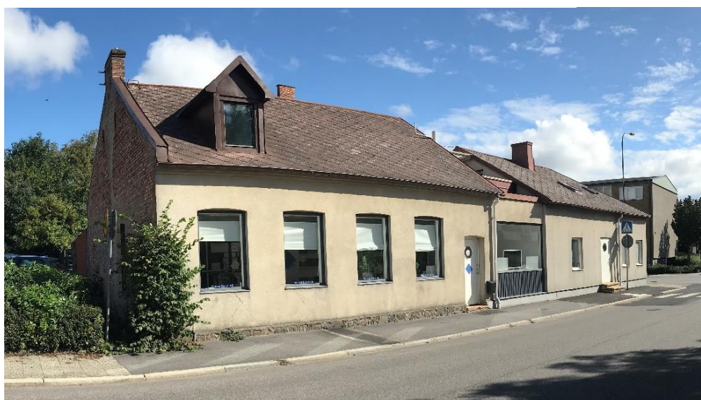
Befintlig bebyggelse inom planområdet sett från Repslagaregatan
