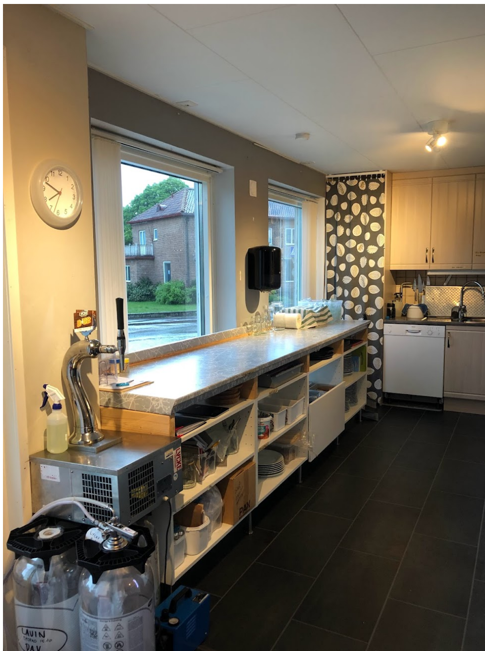
Platsbyggd arbetsbänk med lättskött yta. Regjäla utrymmen under som är lätt åtkomliga. Lite vask längst in men disken går helt åt andra hållet. Inga korsande flöden med mat och disk
