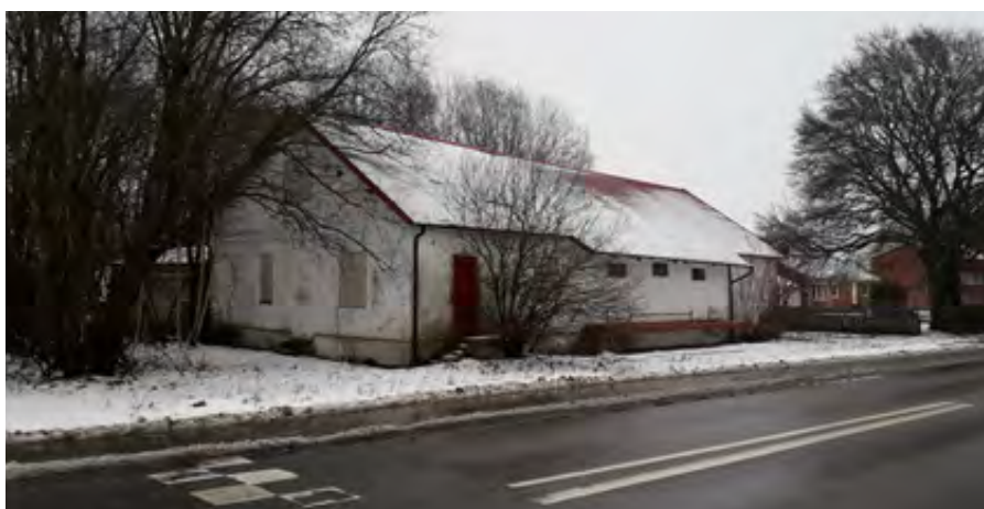
Bild 9. Del av mejeribyggnaden som vetter mot väg 13/Röstångavägen.
